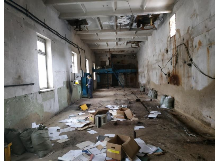
Внутренние помещения здания котельной
