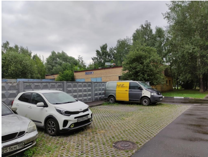
Общий вид здания котельной
