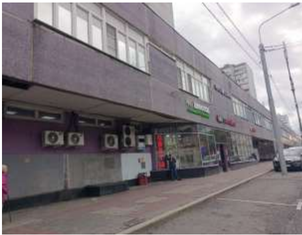
Фото 3. Внешний вид здания
