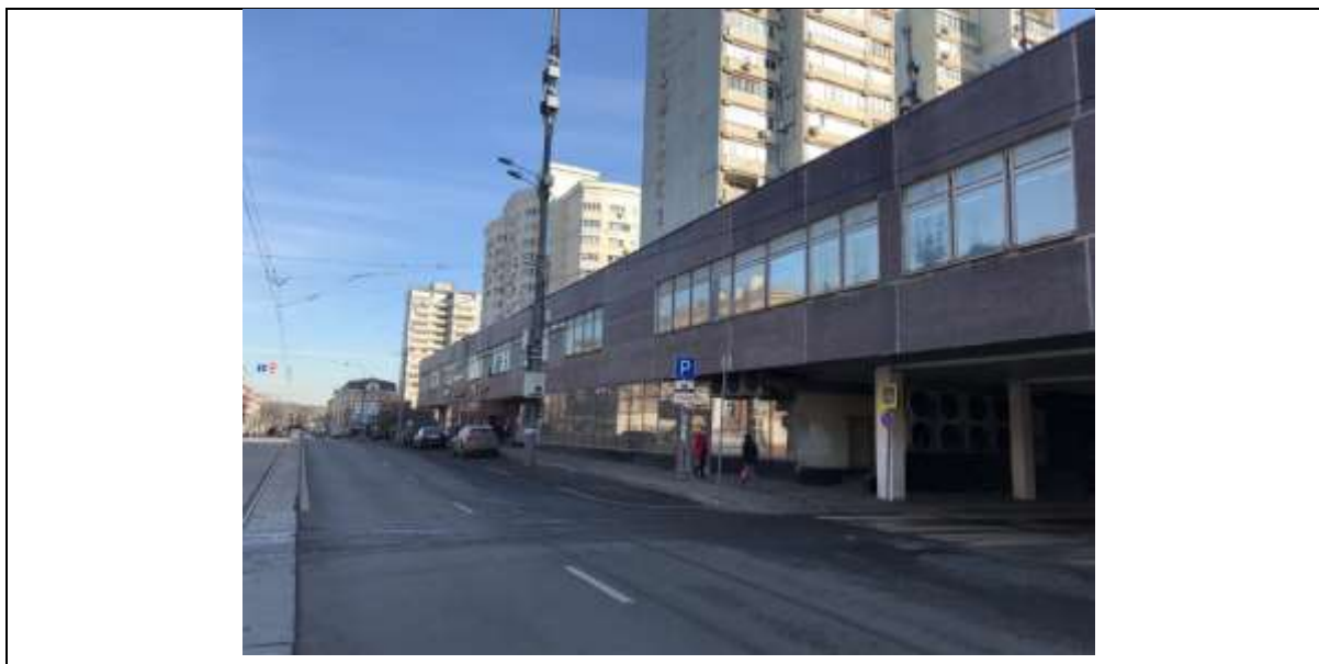
Фото 1. Внешний вид здания
