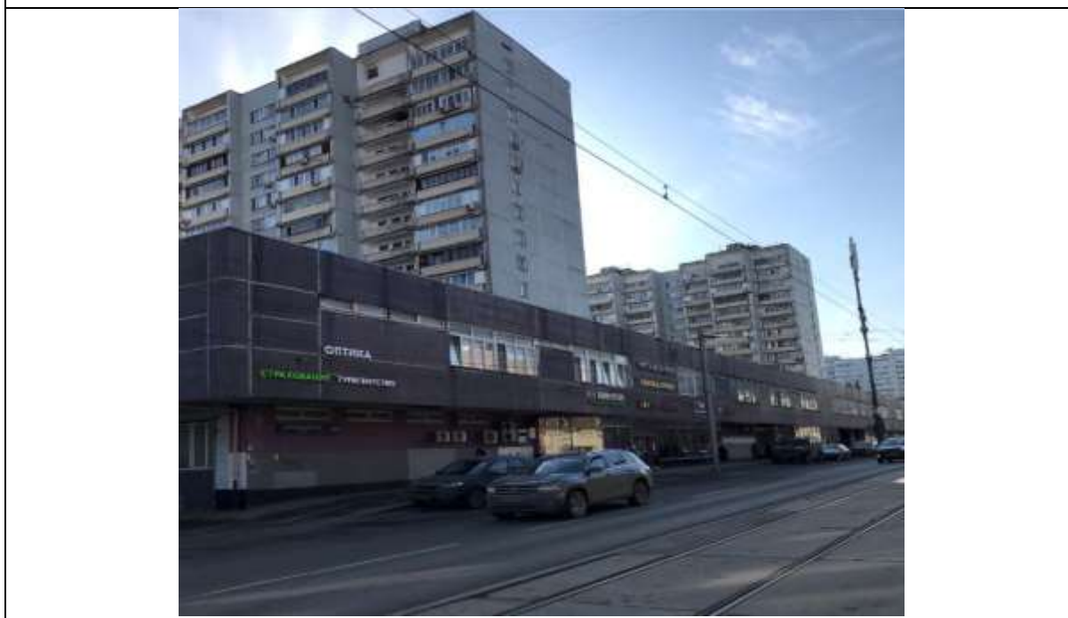
Фото 2. Внешний вид здания
