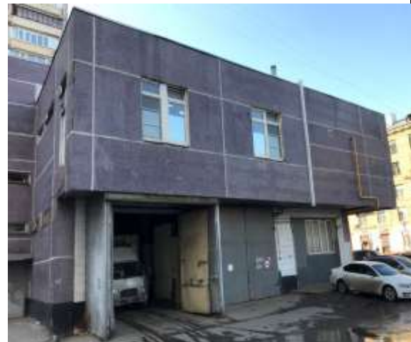
Фото 4. Внешний вид здания
