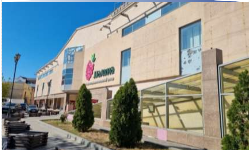
Источники: Данные визуального осмотра
