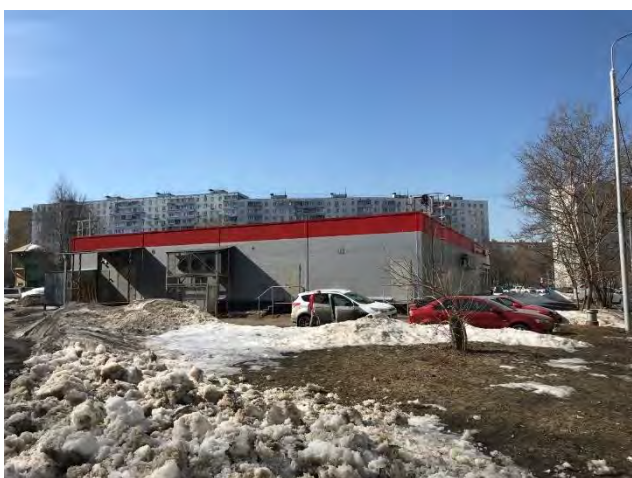
Фото 5. Внешний вид здания
