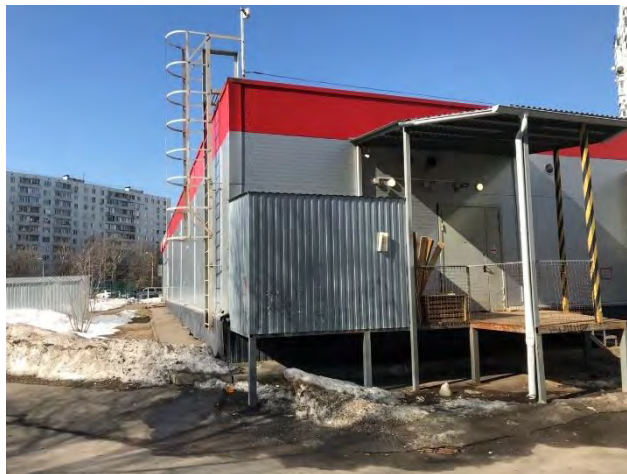
Фото 4. Внешний вид здания
