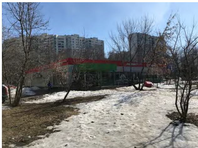
Фото 1. Внешний вид здания
