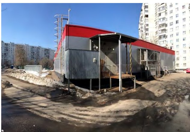
Фото 7. Внешний вид здания
