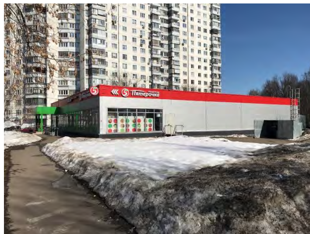
Фото 2. Внешний вид здания
