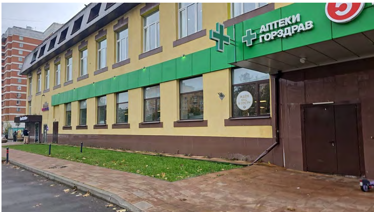
Фото 1. Внешний вид здания
