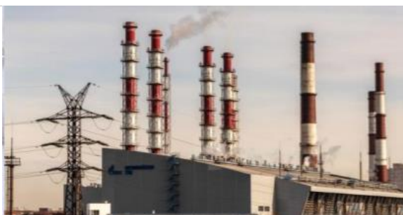
Бывший турбинный цех ТЭЦ-14 под ЦОД, Санкт-Петербург (ГВА ~29 тыс. кв. м)
