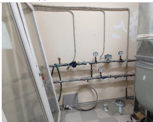
Фото 114. Внутренние помещения 2-го этажа
