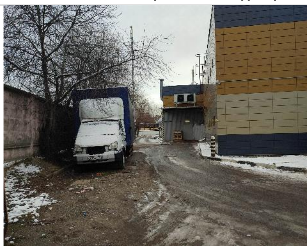
Фото 16. Фасад здания и прилегающая территория
