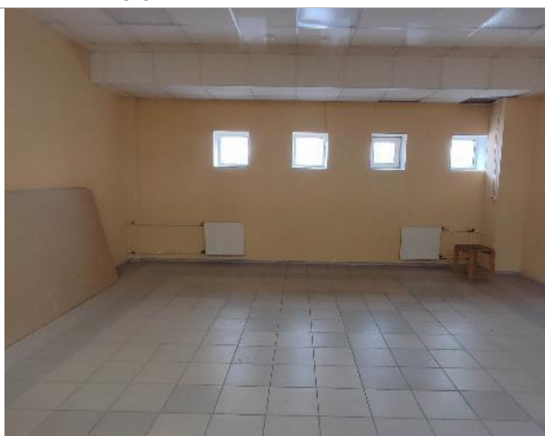
Фото 82. Внутренние помещения 2-го этажа
