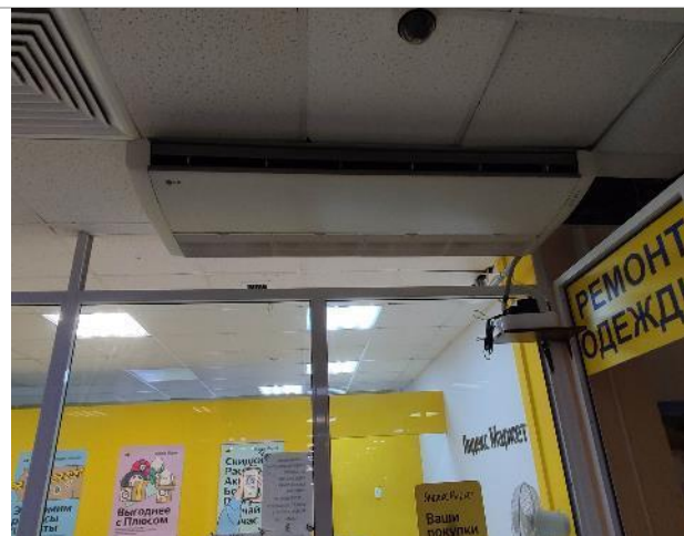
Фото 73. Внутренние помещения 2-го этажа
