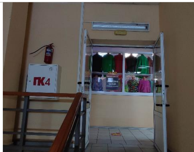
Фото 67. Внутренние помещения 2-го этажа
