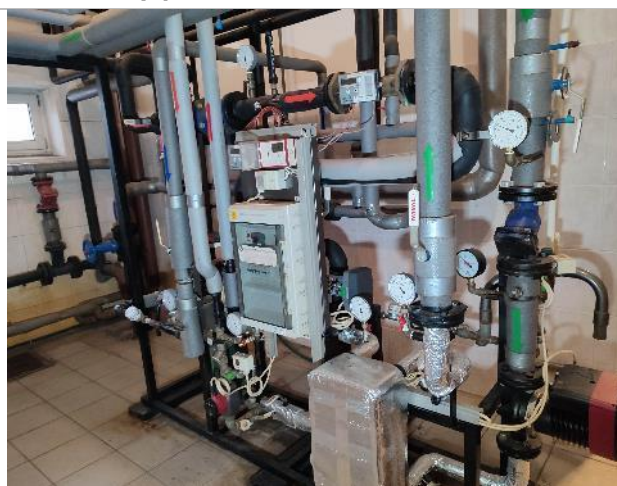
Фото 59. Внутренние помещения 1-го этажа
