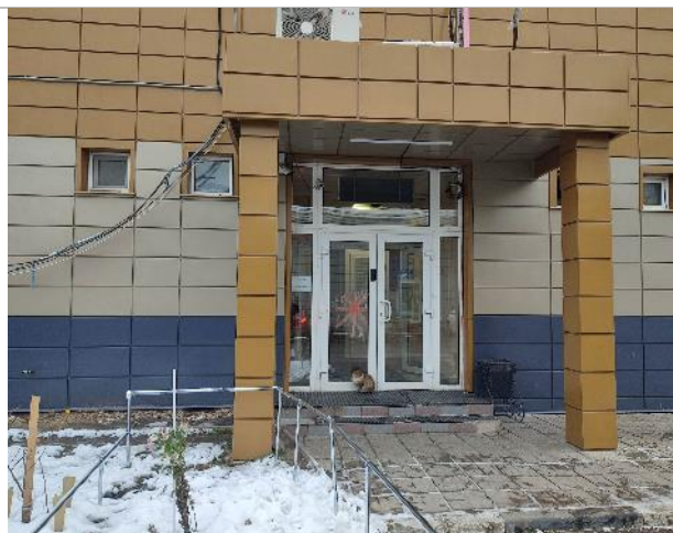
Фото 20. Фасад здания и прилегающая территория
