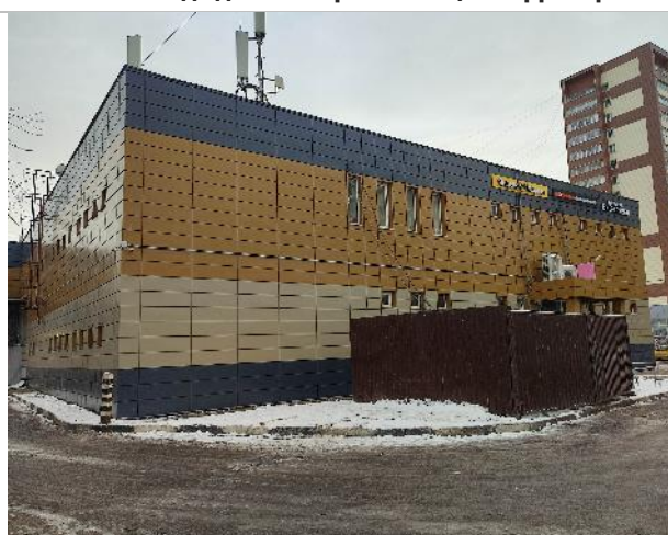
Фото 18. Фасад здания и прилегающая территория
