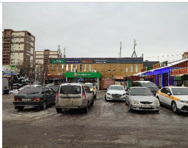
Фото 1. Фасад здания и прилегающая территория
