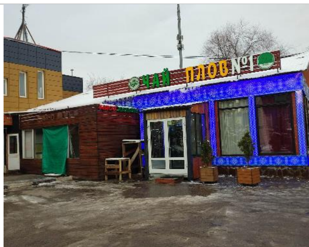
Фото 4. Фасад здания и прилегающая территория
