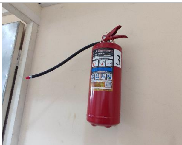
Фото 112. Внутренние помещения 2-го этажа
