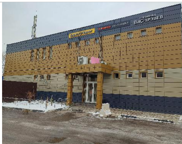
Фото 14. Фасад здания и прилегающая территория
