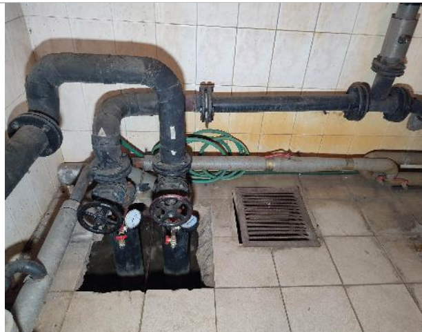
Фото 61. Внутренние помещения 1-го этажа
