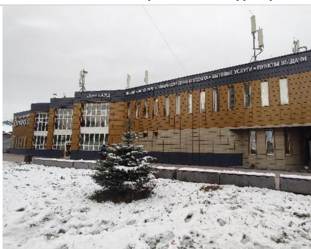
Фото 10. Фасад здания и прилегающая территория
