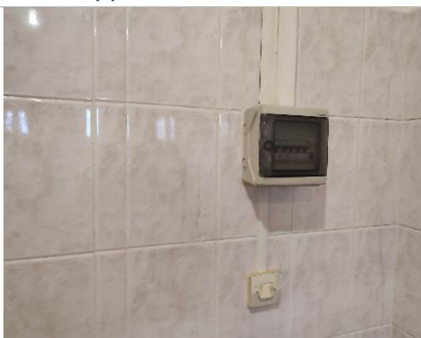
Фото 58. Внутренние помещения 1-го этажа
