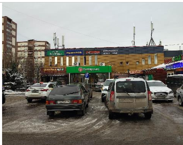
Фото 3. Фасад здания и прилегающая территория
