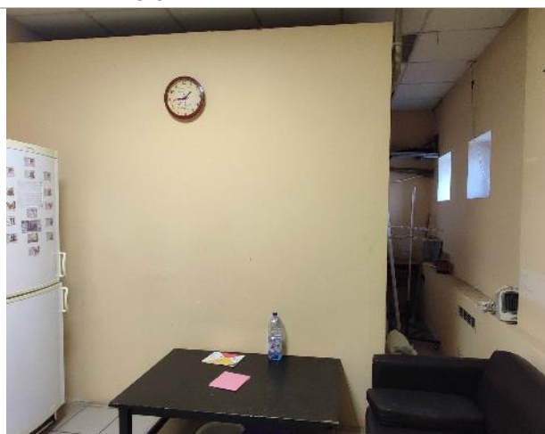
Фото 106. Внутренние помещения 2-го этажа
