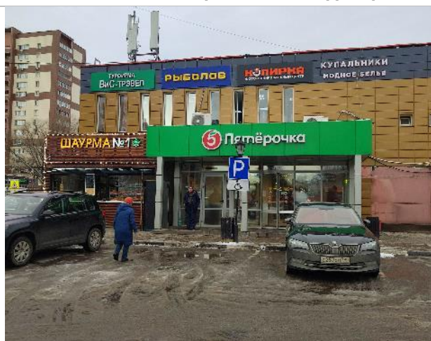
Фото 5. Фасад здания и прилегающая территория
