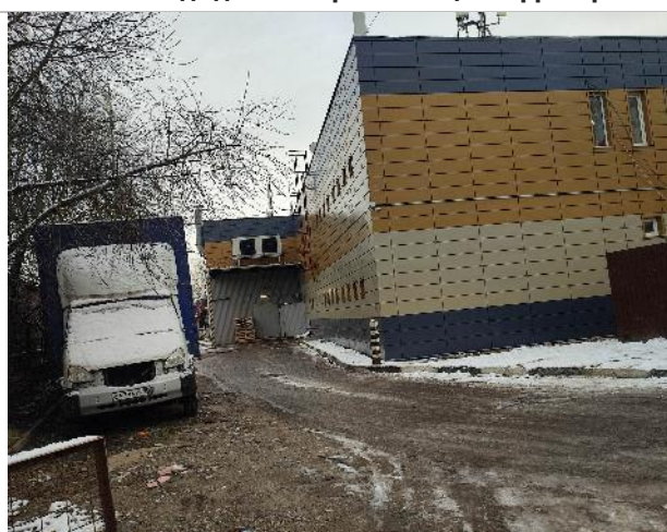
Фото 17. Фасад здания и прилегающая территория
