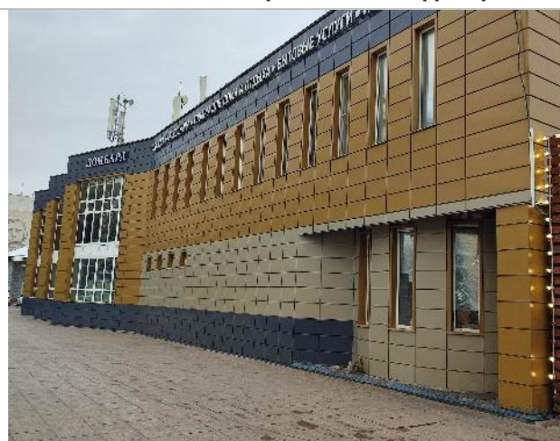
Фото 9. Фасад здания и прилегающая территория
