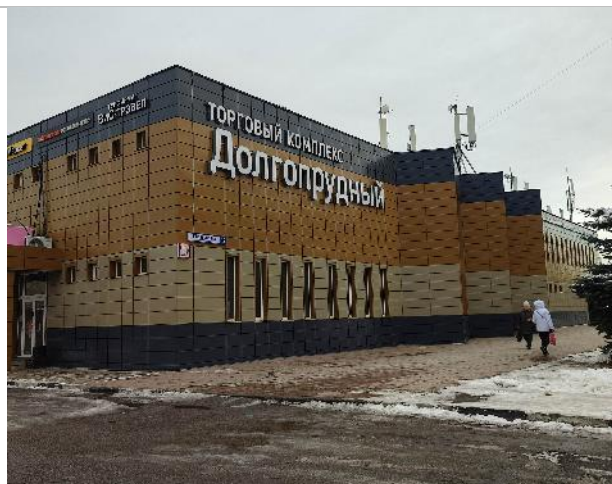
Фото 13. Фасад здания и прилегающая территория
