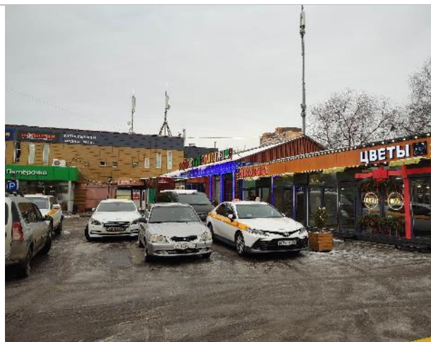
Фото 2. Фасад здания и прилегающая территория
