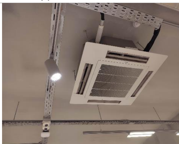
Фото 40. Внутренние помещения 1-го этажа
