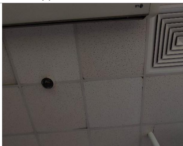
Фото 72. Внутренние помещения 2-го этажа
