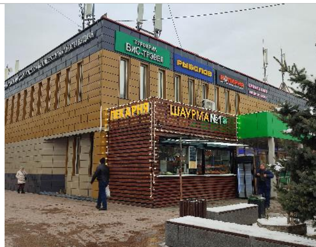
Фото 7. Фасад здания и прилегающая территория
