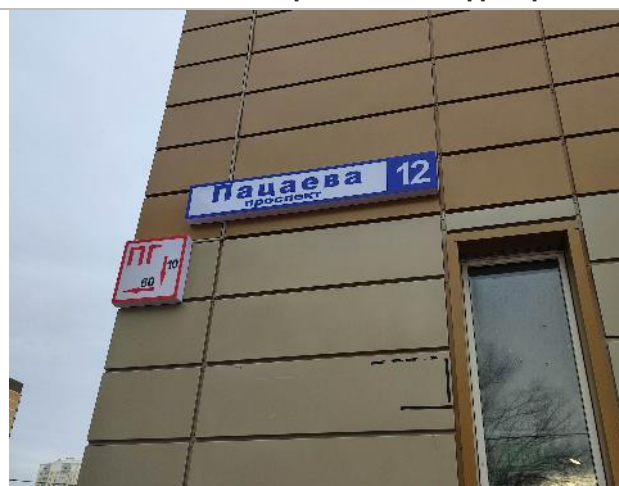
Фото 11. Фасад здания и прилегающая территория
