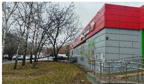
Фотография 3.4. Прилегающая территория, фасад здания
