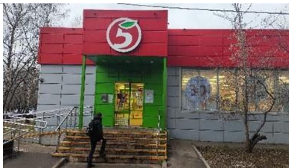
Фотография 3.3. Прилегающая территория, фасад здания
