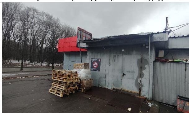
Фото 8. Прилегающая территория и фасад здания.
