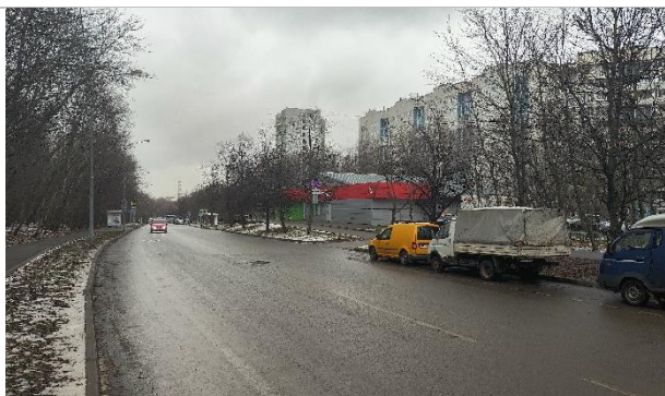
Фото 10. Прилегающая территория и фасад здания.
