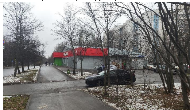
Фото 13. Прилегающая территория и фасад здания.
