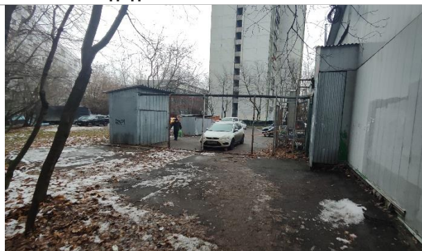
Фото 6. Прилегающая территория и фасад здания.
