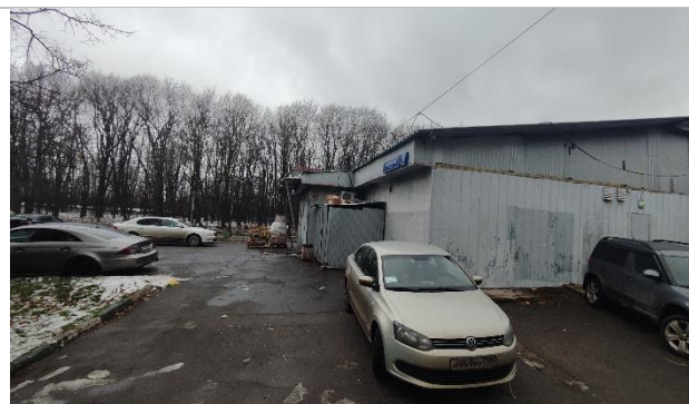
Фото 9. Прилегающая территория и фасад здания.
