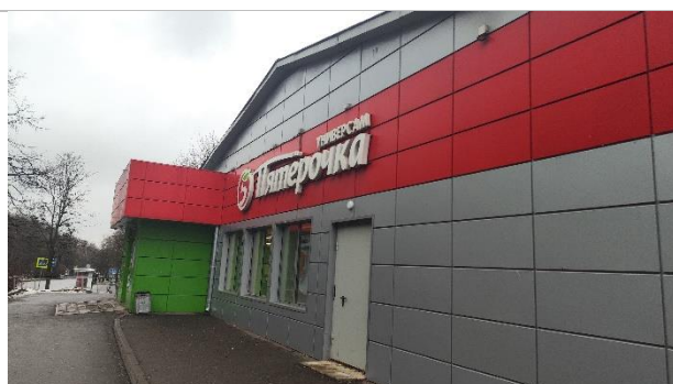
Фотография 3.3. Прилегающая территория, фасад здания
