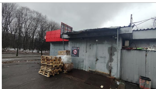
Фотография 3.4. Прилегающая территория, фасад здания
