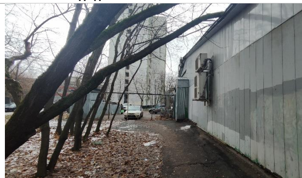
Фото 5. Прилегающая территория и фасад здания.
