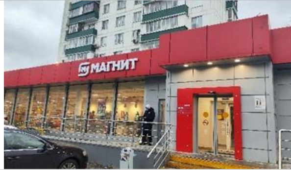
Фотография 3.4. Прилегающая территория, фасад здания
