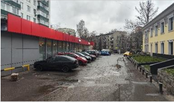
Фотография 3.3. Прилегающая территория, фасад здания
