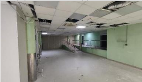
Фотография 3.7. Состояние внутренних помещений
