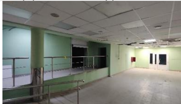
Фотография 3.8. Состояние внутренних помещений
