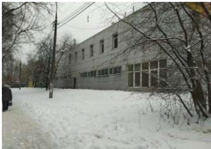
Общий вид здания площадью 2 110 кв. м, фасад здания
