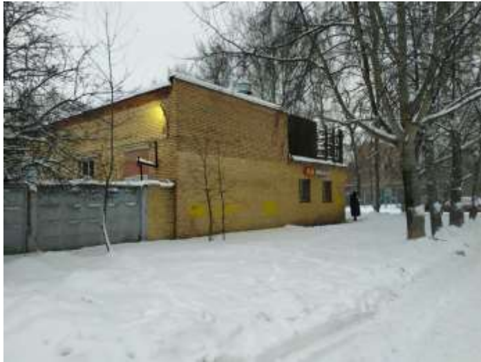
Общий вид здания котельной
