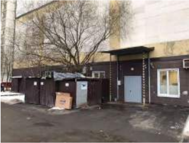
Фото 3. Внешний вид здания, вход в оцениваемые помещения
