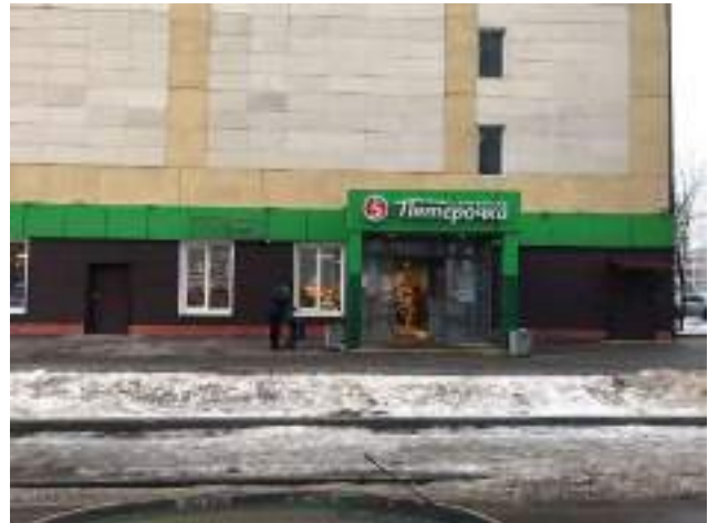
Фото 2. Внешний вид здания, вход в оцениваемые помещения
