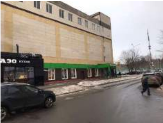
Фото 1. Внешний вид здания, вход в оцениваемые помещения
