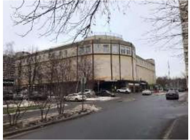
Фото 4. Внешний вид здания
