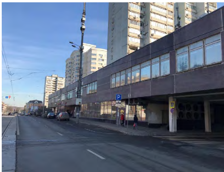
Фото 1. Внешний вид здания
