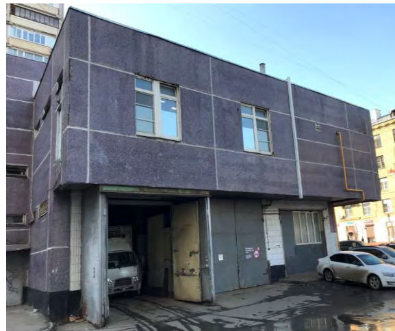
Фото 4. Внешний вид здания
