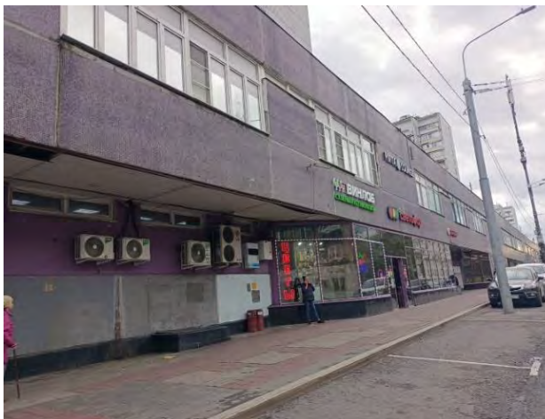
Фото 3. Внешний вид здания
