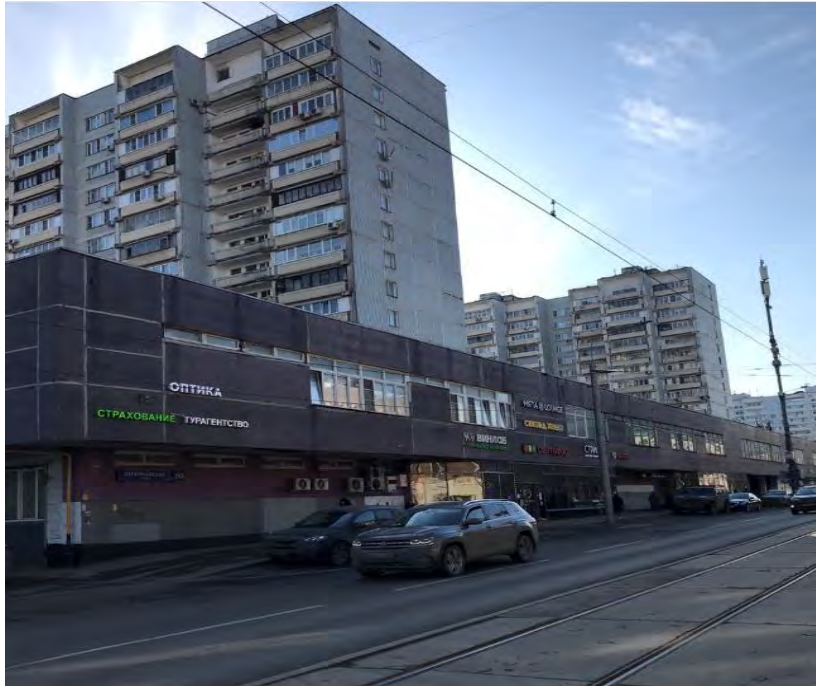
Фото 2. Внешний вид здания
