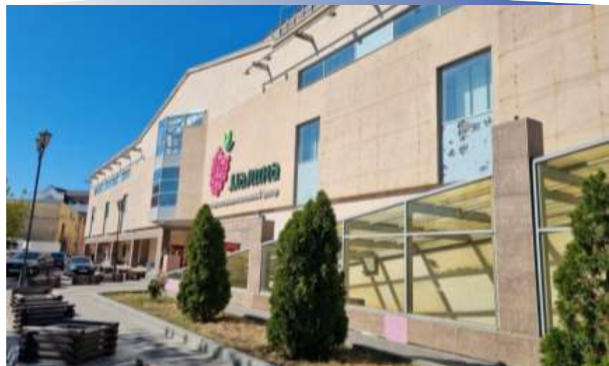
Источники: Данные визуального осмотра
