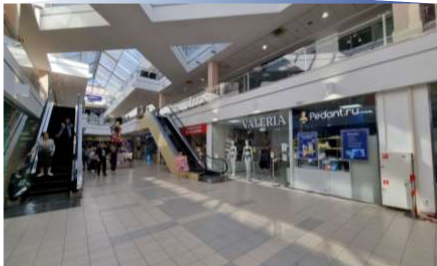
Источники: Данные визуального осмотра
