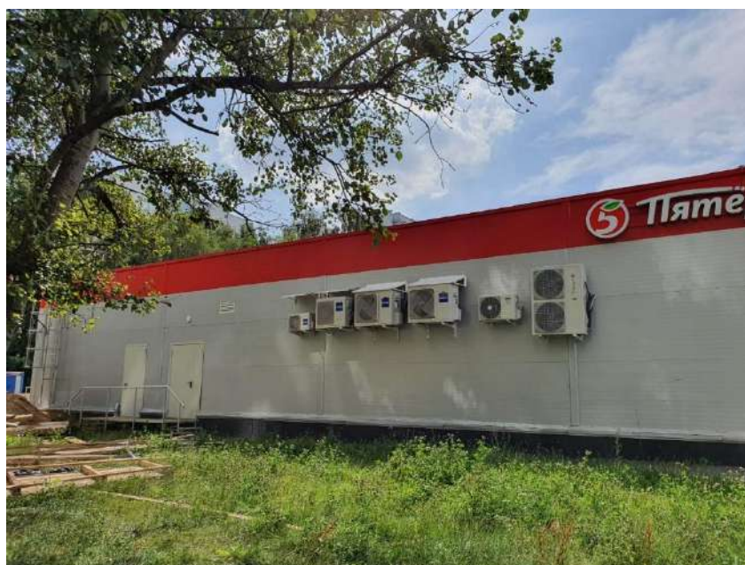
Фото 3. Внешний вид здания
