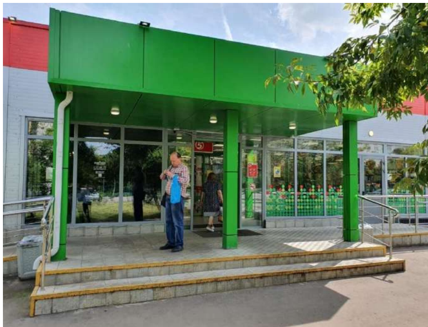
Фото 5. Внешний вид здания
