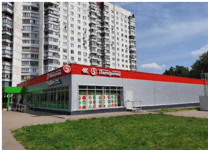
Фото 1. Внешний вид здания
