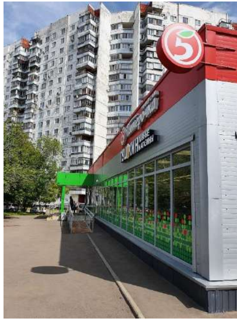
Фото 4. Внешний вид здания
