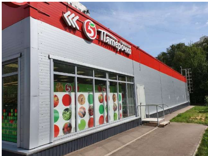
Фото 2. Внешний вид здания
