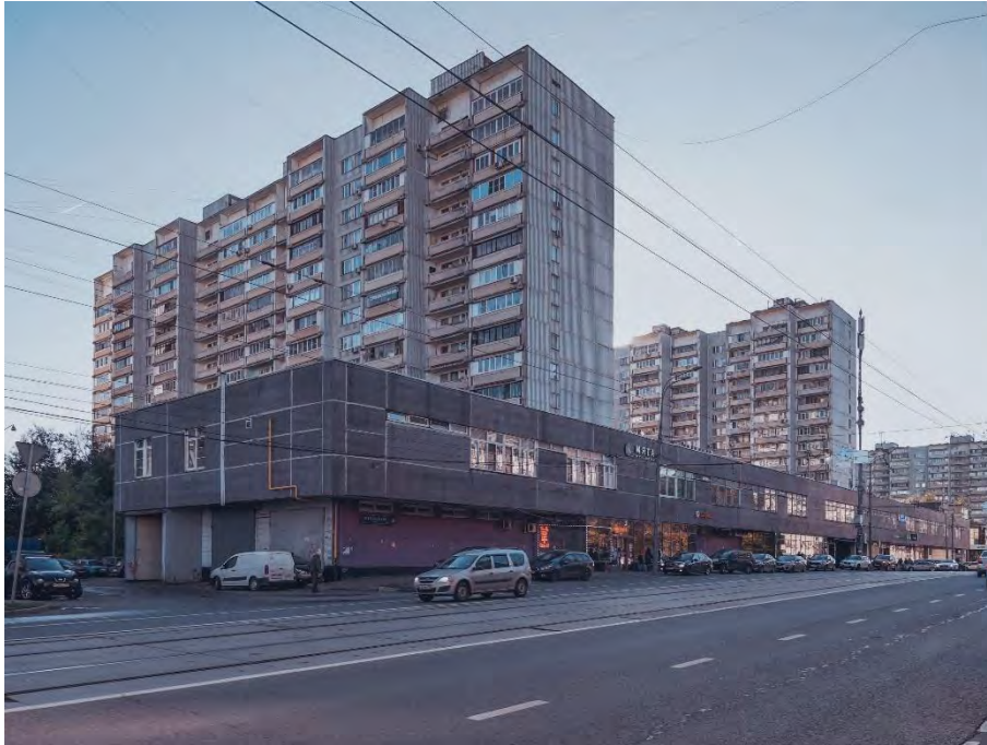
Фото 2. Внешний вид здания
