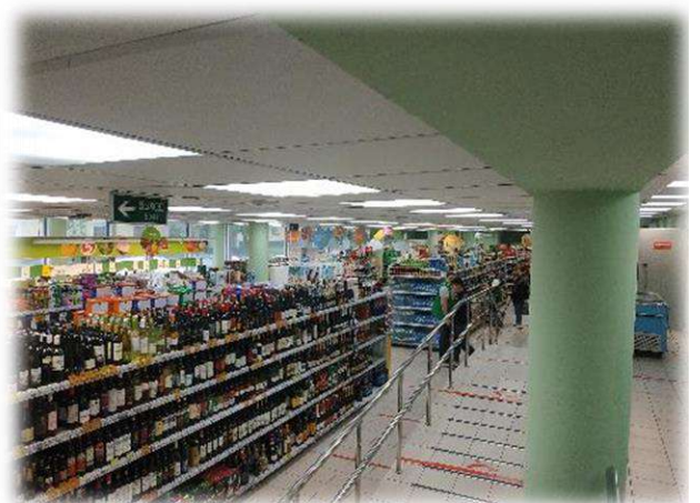
Фотография 3.6. Состояние внутренних помещений
