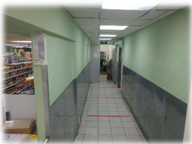
Фотография 3.9. Состояние внутренних помещений
