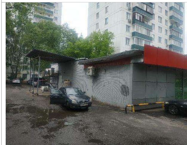
Фото 3. Внешний вид здания
