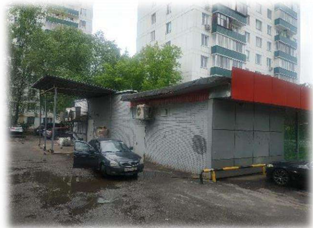
Фотография 3.4. Прилегающая территория, фасад здания
