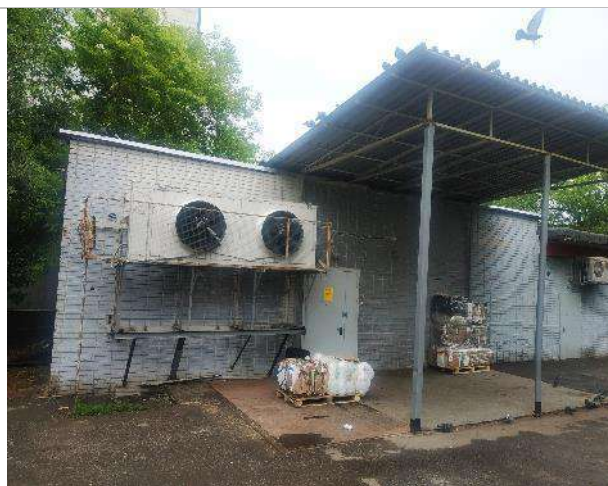
Фото 4. Внешний вид здания
