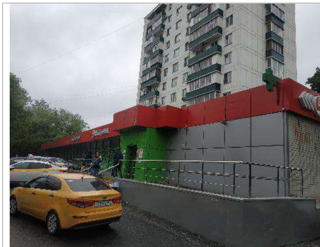
Фото 1. Внешний вид здания
