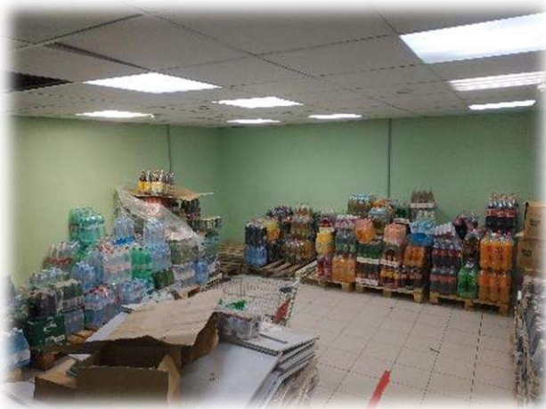
Фотография 3.7. Состояние внутренних помещений
