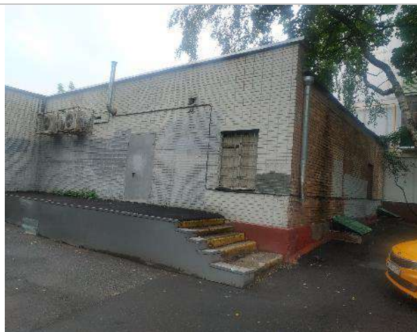
Фото 2. Внешний вид здания
