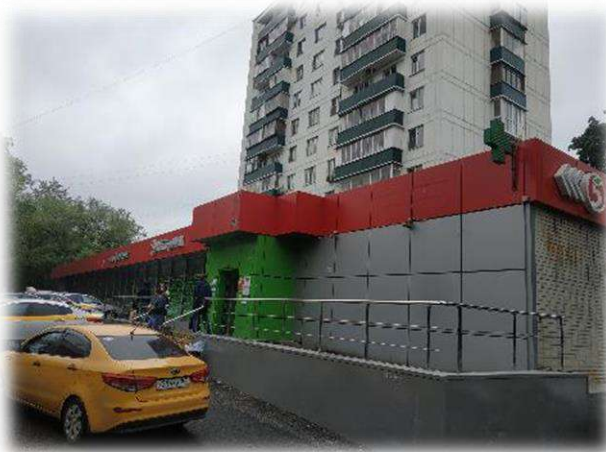
Фотография 3.3. Прилегающая территория, фасад здания
