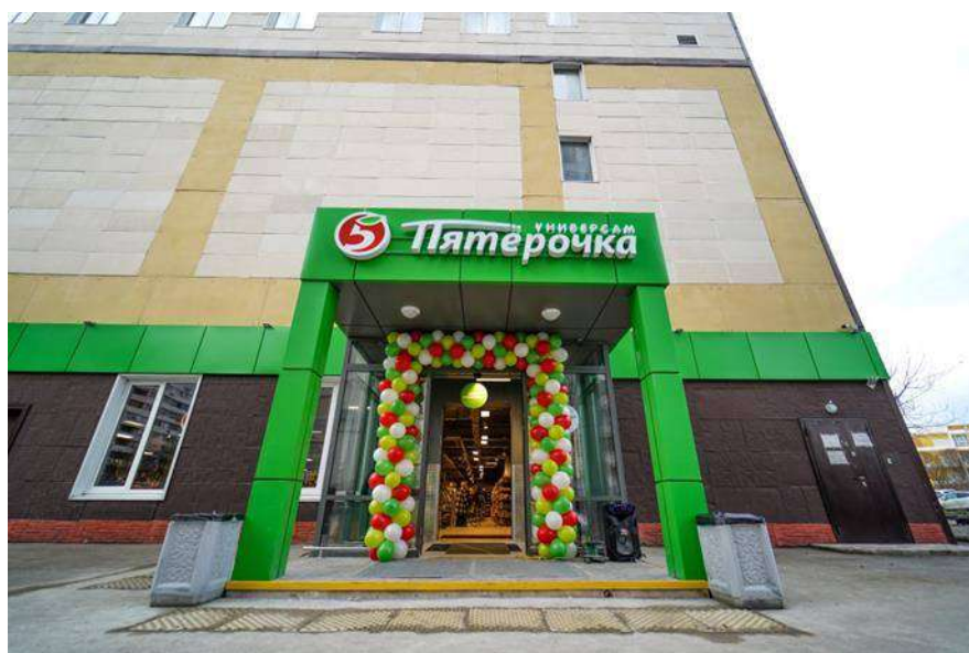
Фото 2. Внешний вид здания, вход в оцениваемые помещения
