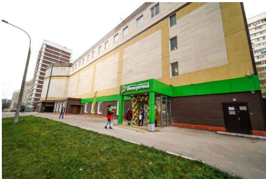
Фото 1. Внешний вид здания, вход в оцениваемые помещения
