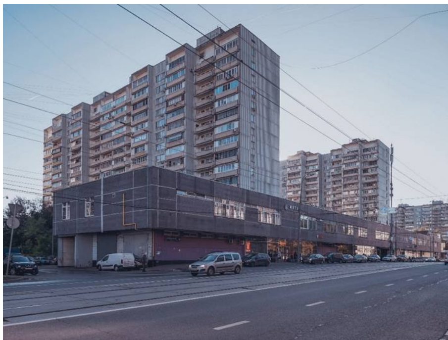
Фото 2. Внешний вид здания
