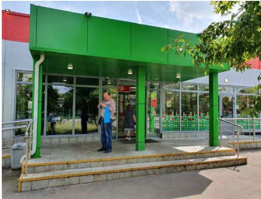
Фото 5. Внешний вид здания
