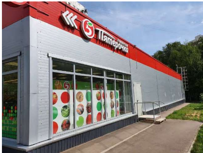
Фото 2. Внешний вид здания
