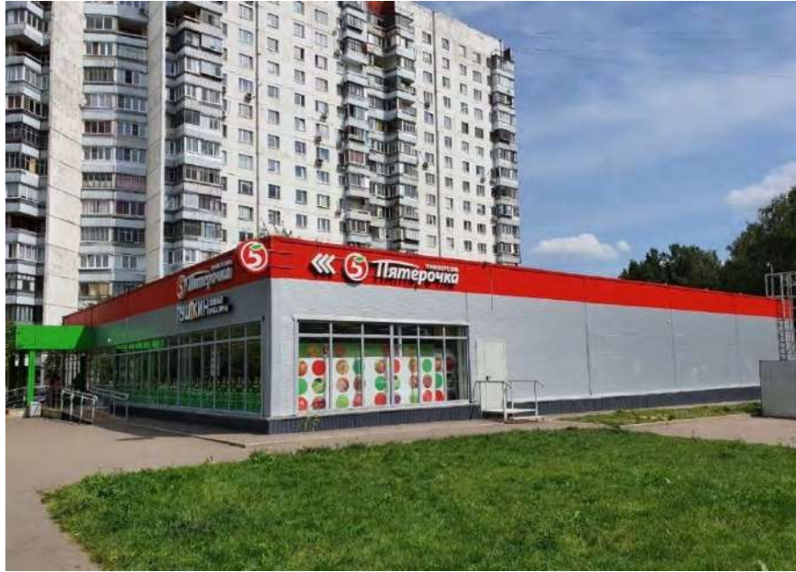
Фото 1. Внешний вид здания
