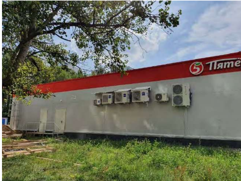
Фото 3. Внешний вид здания
