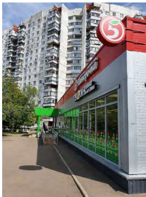
Фото 4. Внешний вид здания
