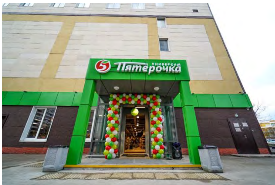
Фото 2. Внешний вид здания, вход в оцениваемые помещения
