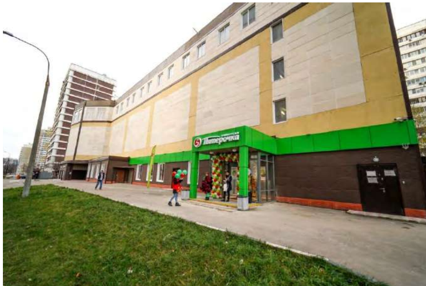
Фото 1. Внешний вид здания, вход в оцениваемые помещения
