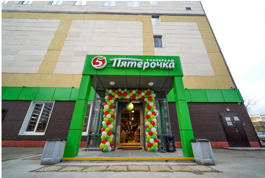
Фото 2. Внешний вид здания
