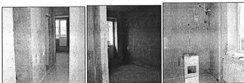
Объекты оценки – внутренние помещения жилых квартир.
