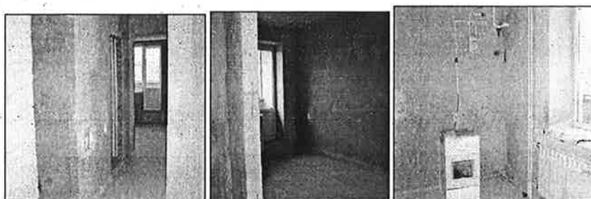
Объекты оценки – внутренние помещения жилых квартир.
