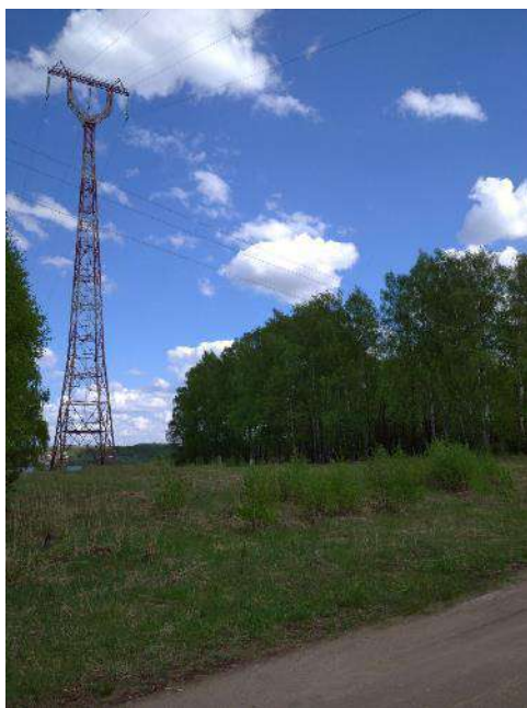
Фото 25. Прилегающая территория и подъездные пути.
