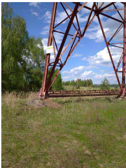
Фото 29. Прилегающая территория и подъездные пути.
