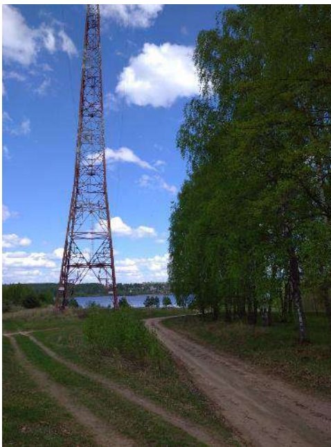
Фото 41. Прилегающая территория и подъездные пути.
