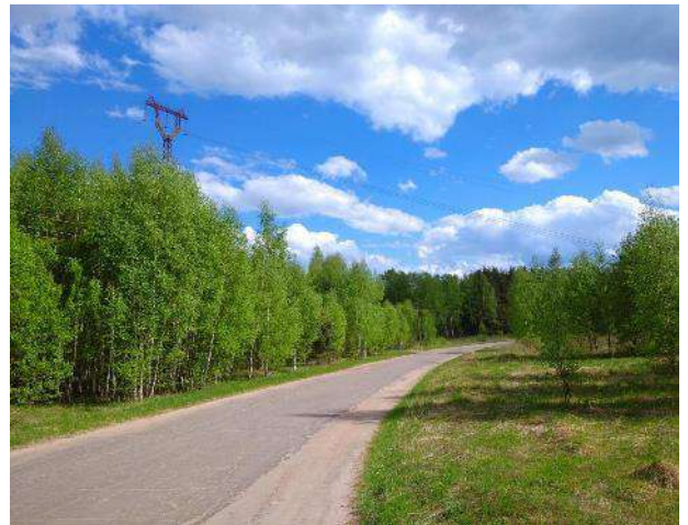
Фото 34. Прилегающая территория и подъездные пути.
