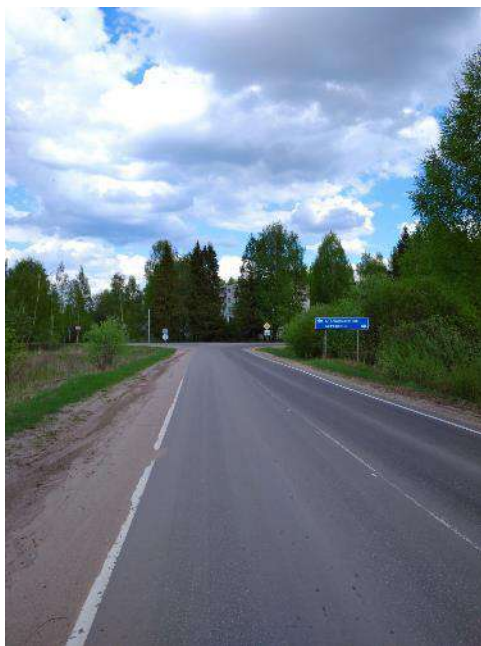
Фото 23. Прилегающая территория и подъездные пути.
