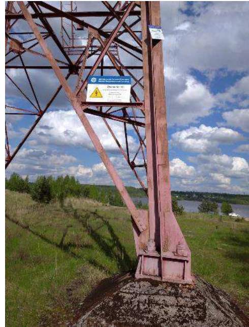
Фото 40. Прилегающая территория и подъездные пути.
