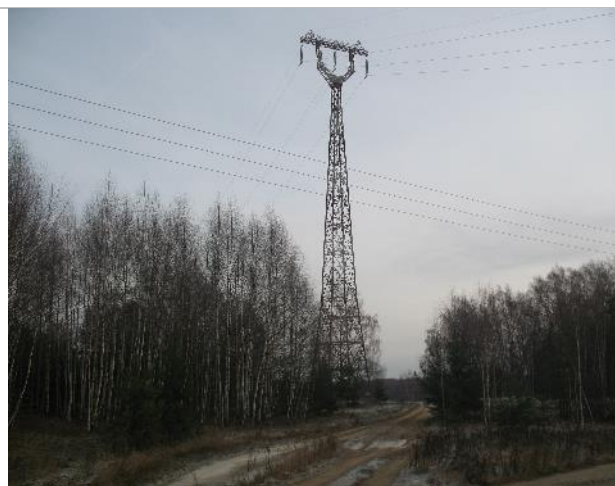
Фото 15. Подъездные пути к участку
