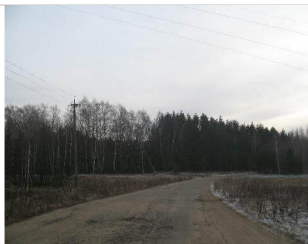
Фото 18. Подъездные пути к участку
