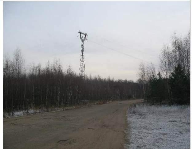
Фото 10. Подъездные пути к участку
