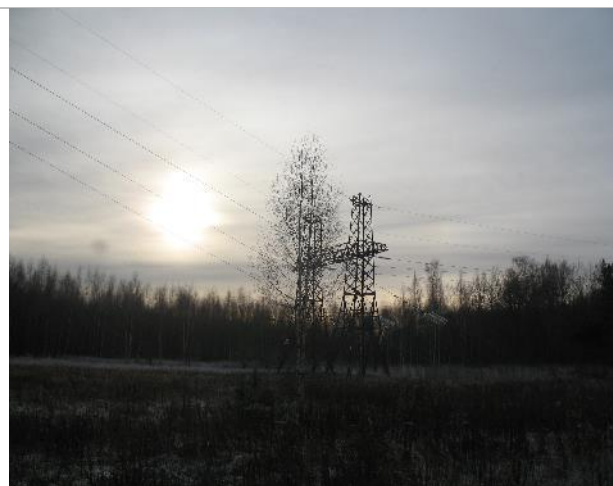
Фото 16. Подъездные пути к участку
