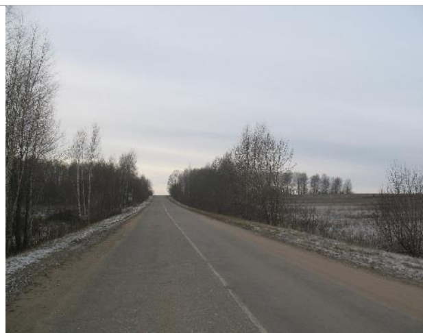
Фото 5. Подъездные пути к участку
