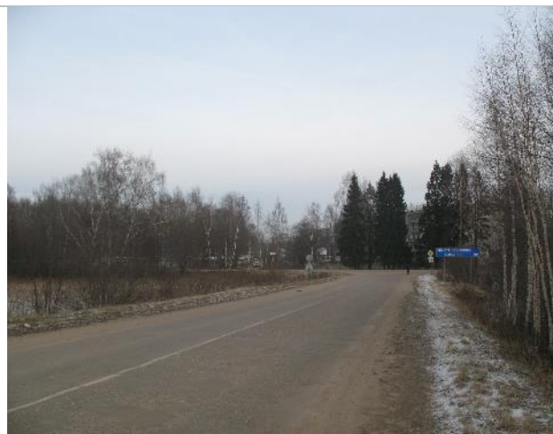
Фото 1. Подъездные пути к участку
