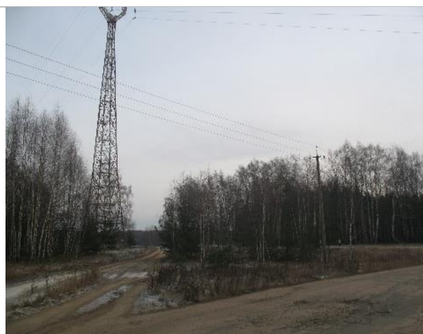
Фото 17. Подъездные пути к участку
