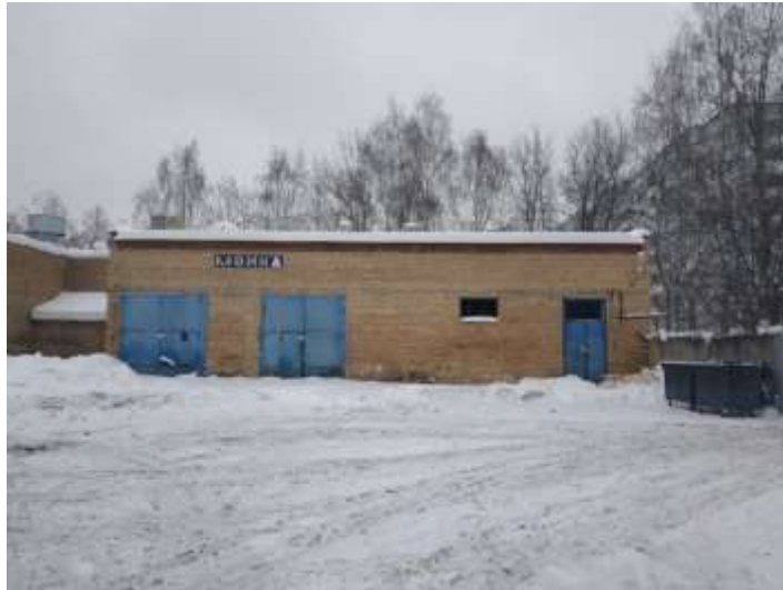
Общий вид здания котельной
