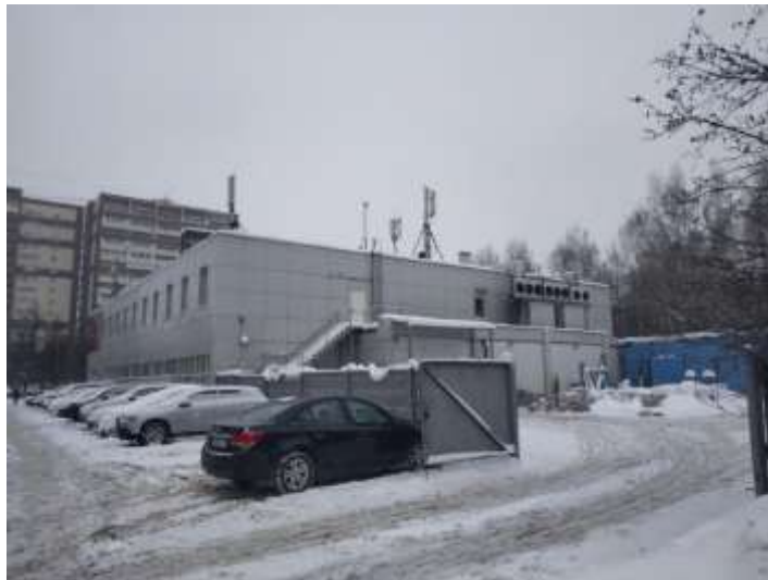
Общий вид здания площадью 2 110,5 кв. м, фасад здания
