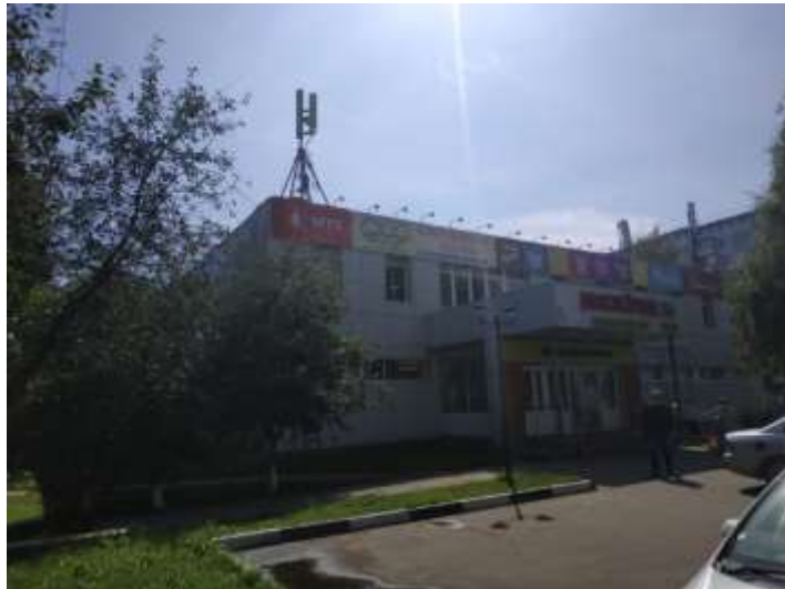
Общий вид здания площадью 2 110,5 кв. м, центральный вход
