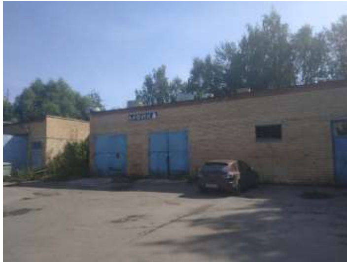
Общий вид здания котельной
