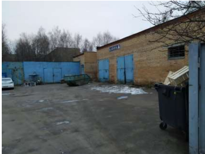
Общий вид здания котельной
