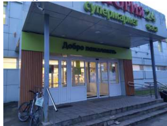
Входная группа здания площадью 2 110,5 кв. м
