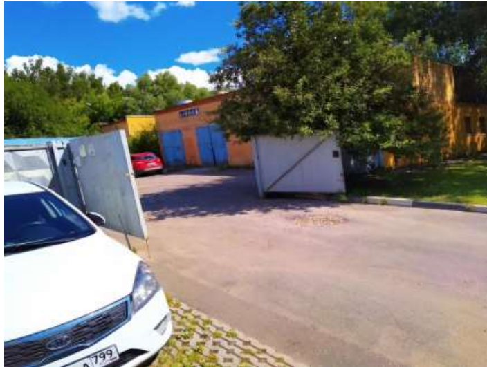
Общий вид здания котельной
