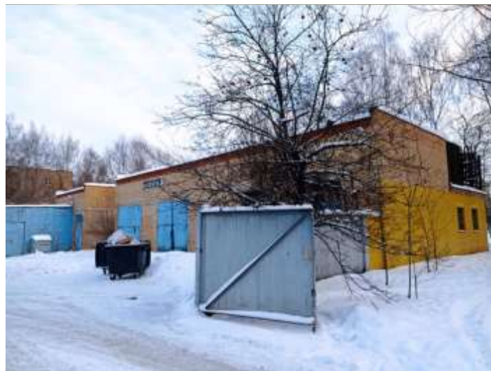
Общий вид здания котельной
