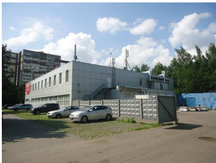
Общий вид здания площадью 2 110,5 кв. м
