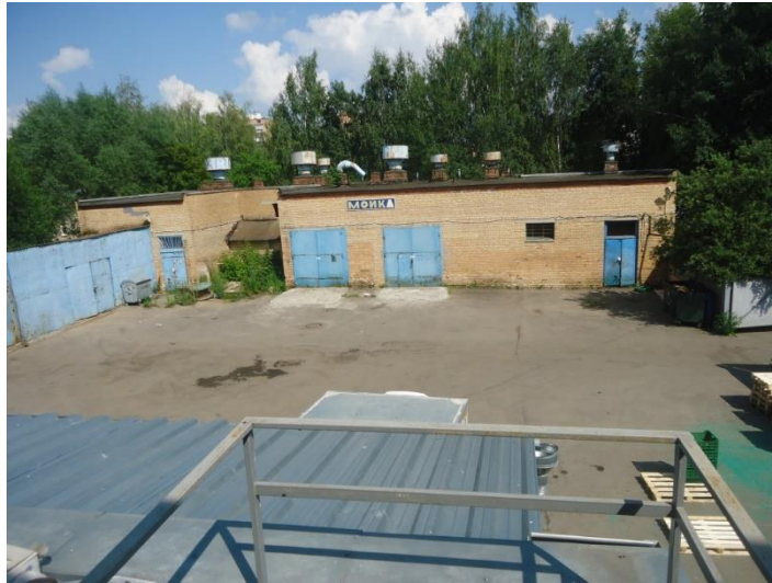
Общий вид здания котельной
