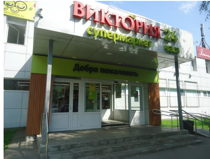
Входная группа здания площадью 2 110,5 кв. м
