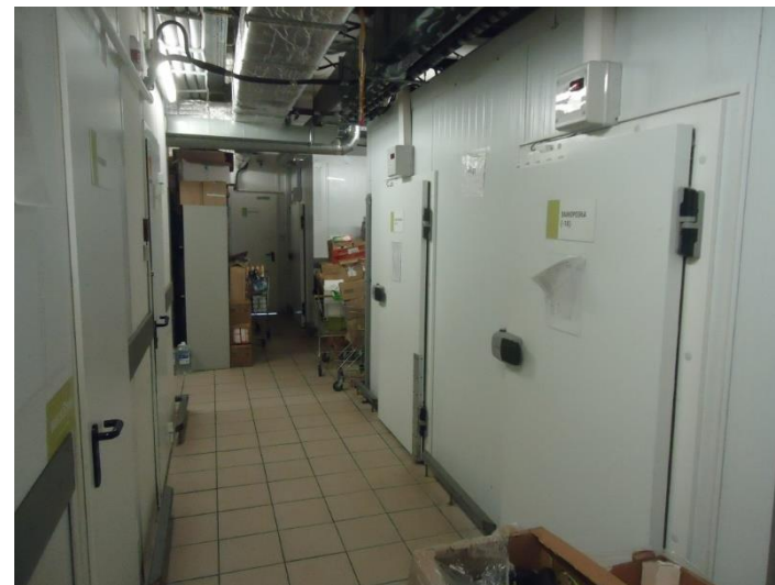
Внутренние помещения здания площадью 2 110,5 кв. м
