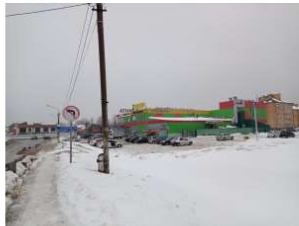
Общий вид здания
