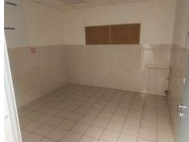
Внутренние помещения (второй этаж)
