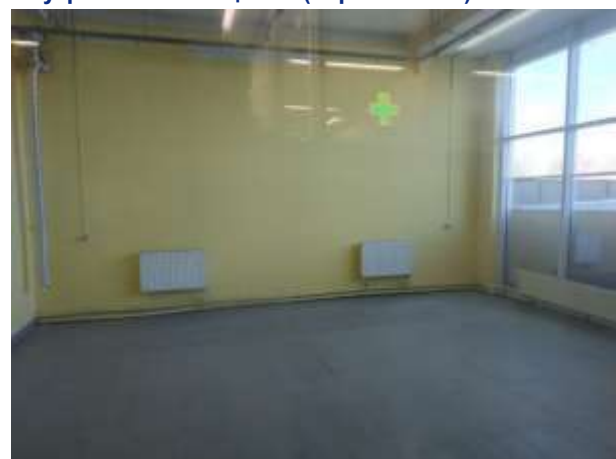
Внутренние помещения (первый этаж)
