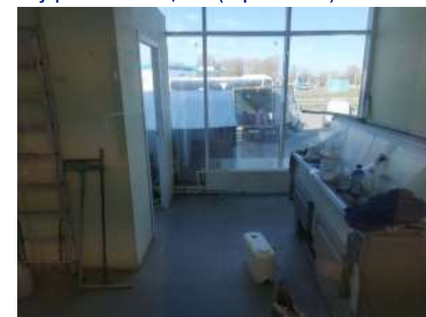
Внутренние помещения (первый этаж)
