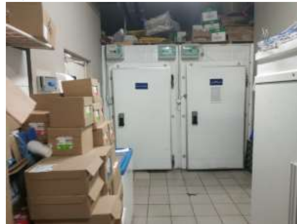
Внутренние помещения (первый этаж)
