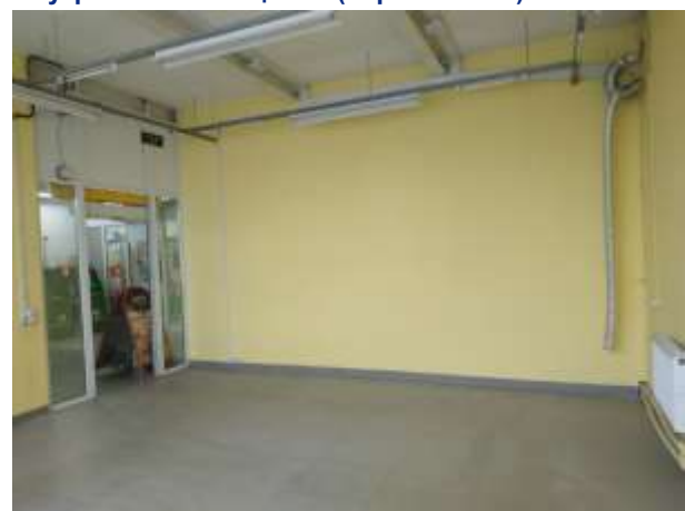
Внутренние помещения (первый этаж)
