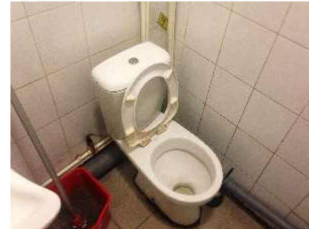
Внутренние помещения (первый этаж)
