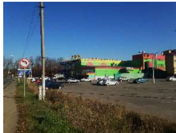
Общий вид здания
