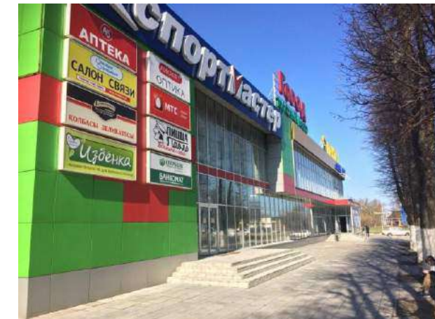
Общий вид здания
