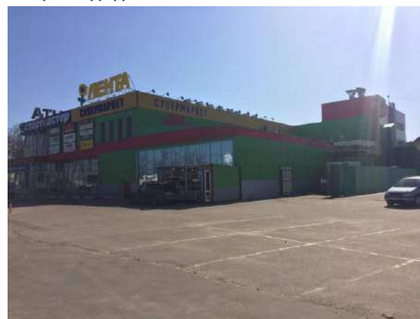
Общий вид здания
