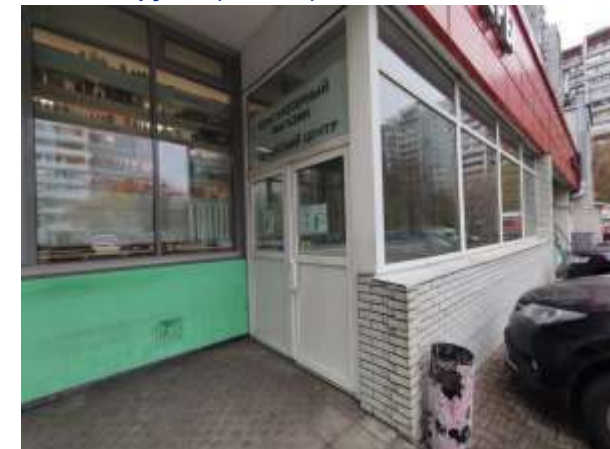
Входная группа (подвал)
