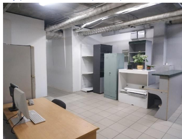
Внутренние помещения (подвал)
