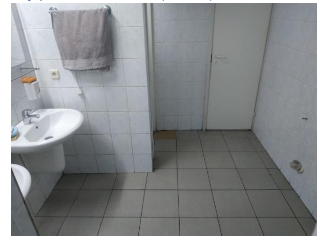
Внутренние помещения (подвал)
