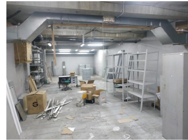
Внутренние помещения (подвал)
