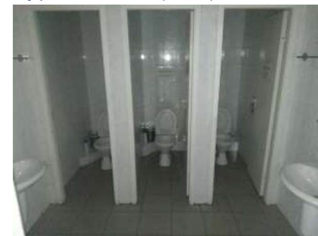
Внутренние помещения (подвал)
