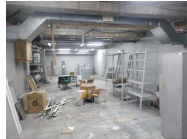
Внутренние помещения (подвал)
