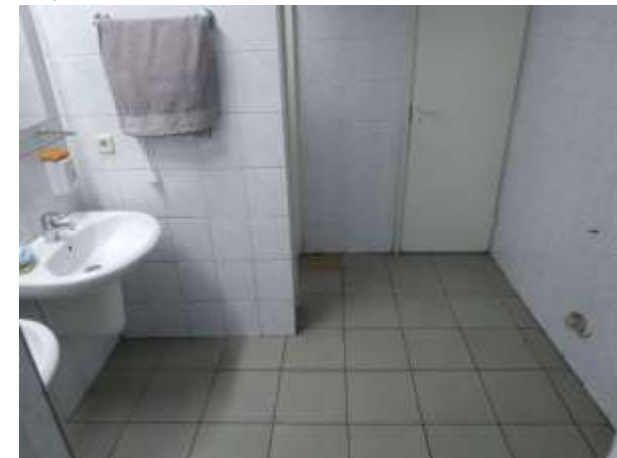
Внутренние помещения (подвал)
