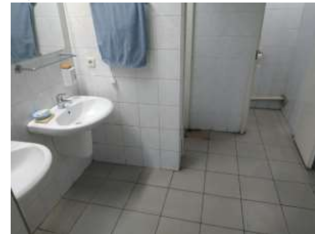
Внутренние помещения (подвал)
