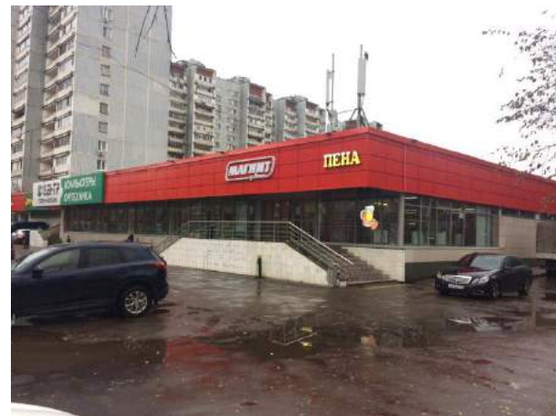
Фасад здания, входная группа
