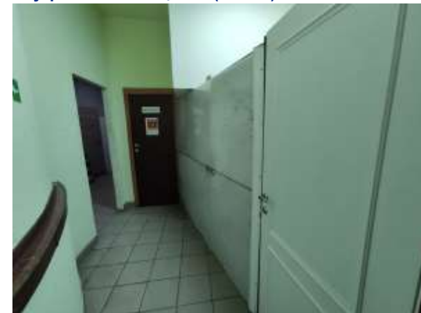
Внутренние помещения (4 этаж)
