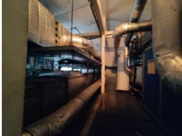
Кровля и техническое помещение (венткамера)
