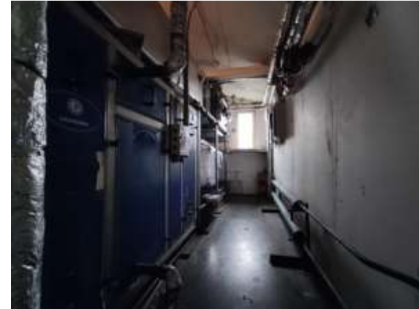
Кровля и техническое помещение (венткамера)
