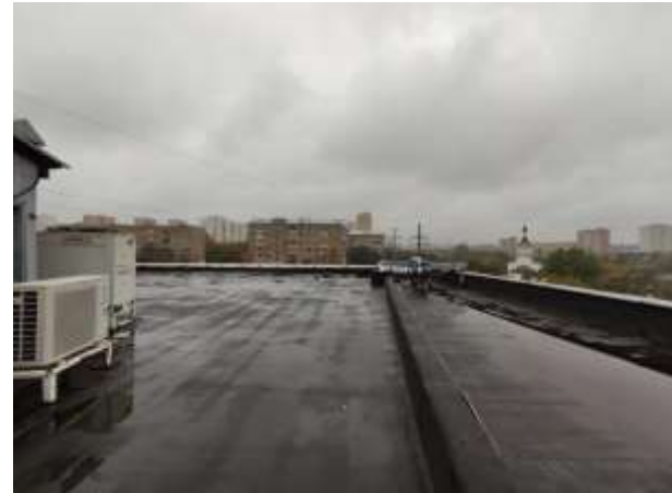
Кровля и техническое помещение (венткамера)
