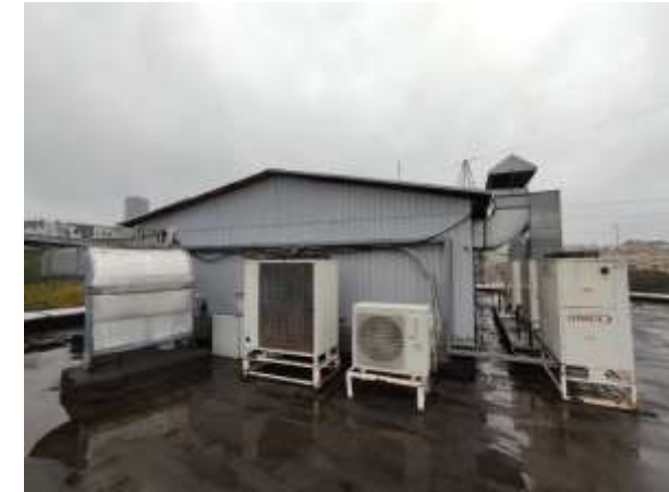
Кровля и техническое помещение (венткамера)
