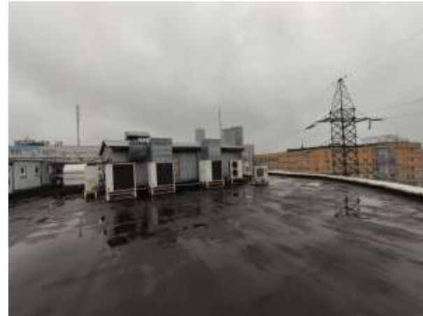
Кровля и техническое помещение (венткамера)
