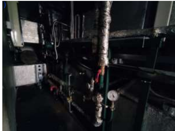
Кровля и техническое помещение (венткамера)
