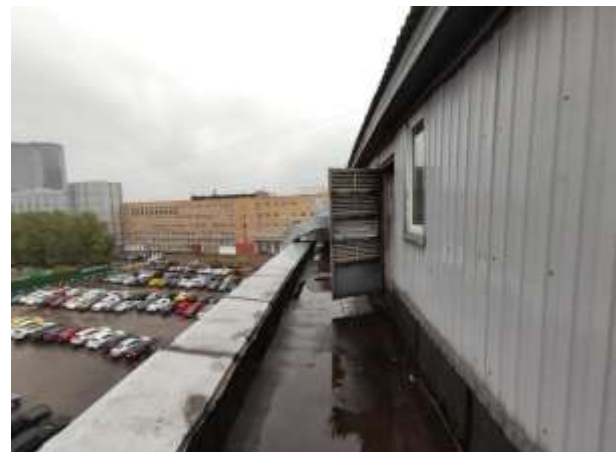
Кровля и техническое помещение (венткамера)
