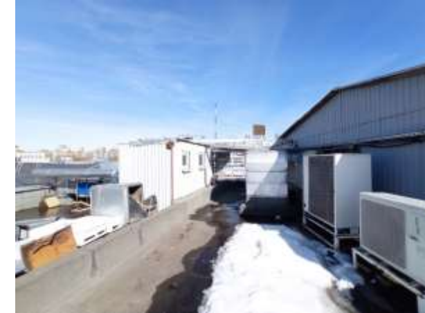
Кровля и техническое помещение (венткамера)
