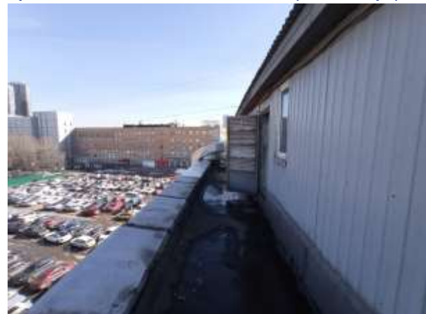
Кровля и техническое помещение (венткамера)
