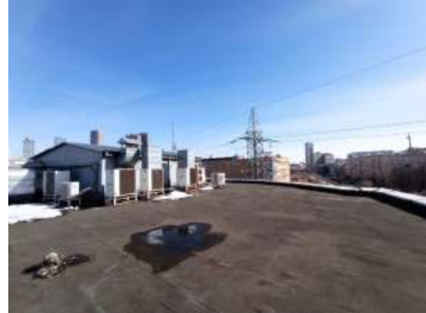
Кровля и техническое помещение (венткамера)
