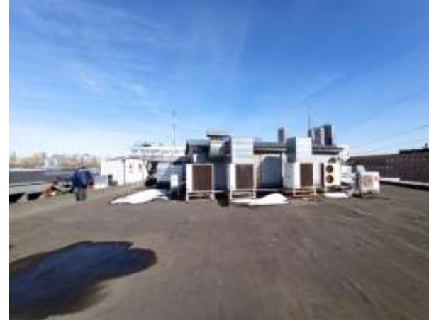
Кровля и техническое помещение (венткамера)
