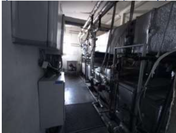
Кровля и техническое помещение (венткамера)
