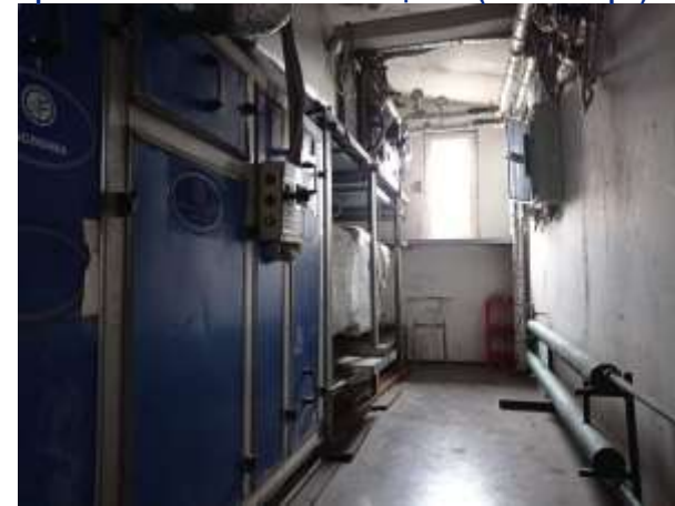
Кровля и техническое помещение (венткамера)
