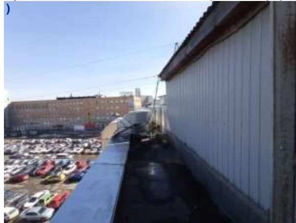
Кровля и техническое помещение (венткамера)
