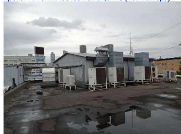
Кровля и техническое помещение (венткамера)
