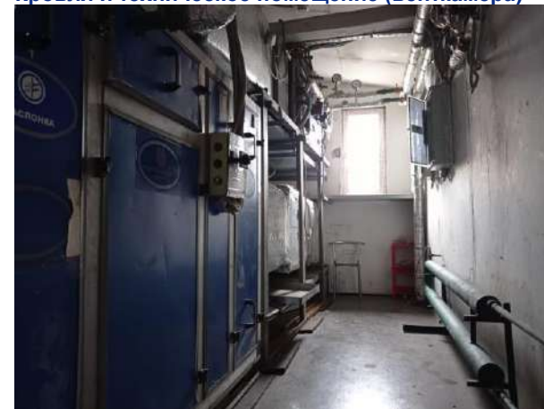
Кровля и техническое помещение (венткамера)
