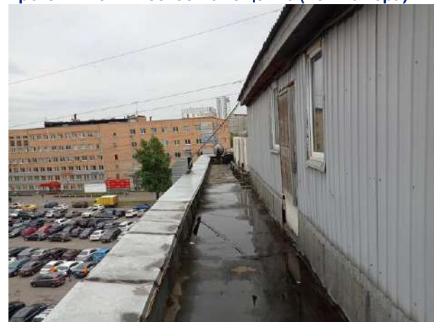
Кровля и техническое помещение (венткамера)
