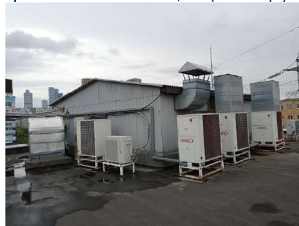
Кровля и техническое помещение (венткамера)
