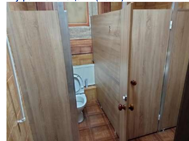
Внутренние помещения (4 этаж)
