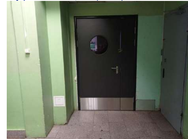
Внутренние помещения (1 этаж)
