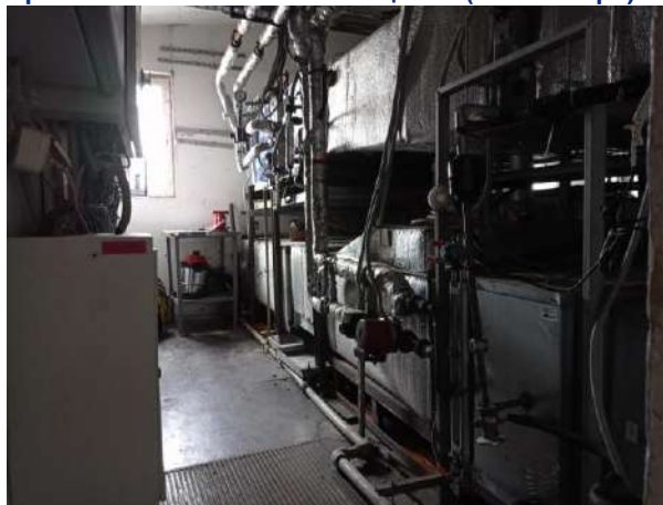
Кровля и техническое помещение (венткамера)
