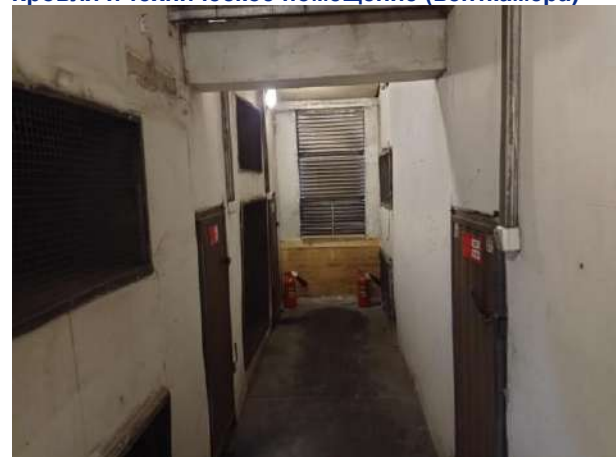
Кровля и техническое помещение (венткамера)
