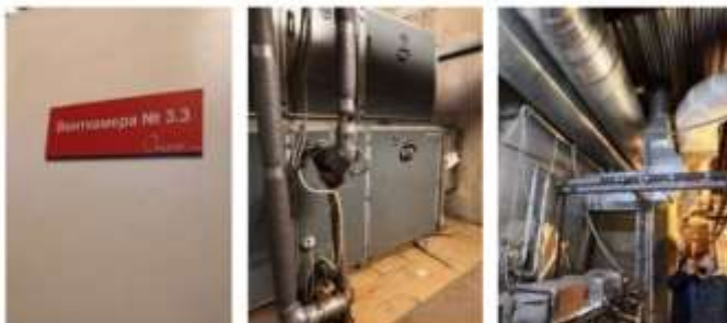
Установка приточно-вытяжной вентиляции
