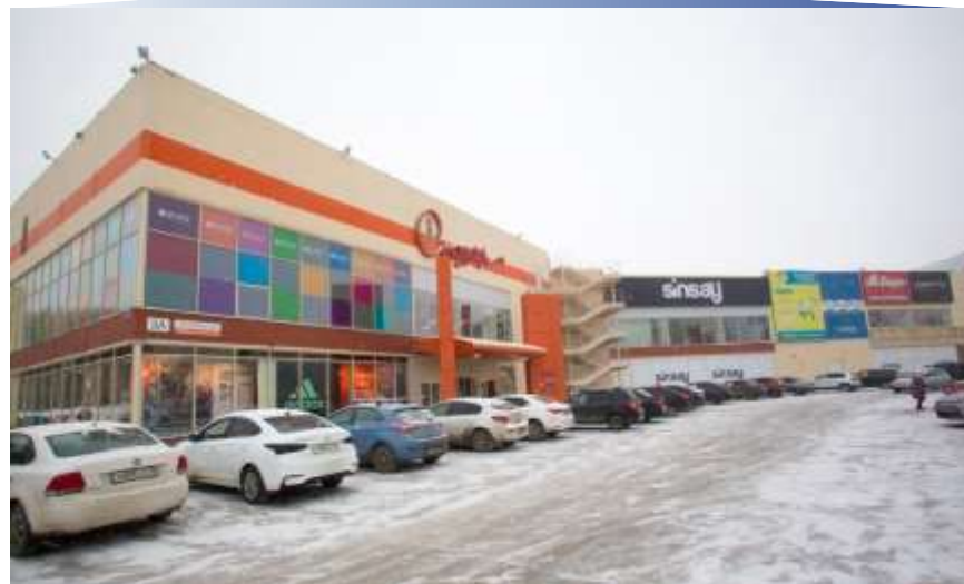
Источники: Данные визуального осмотра
