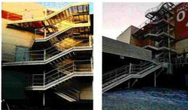
Наружные эвакуационные лестницы
