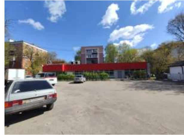
Общий вид здания
