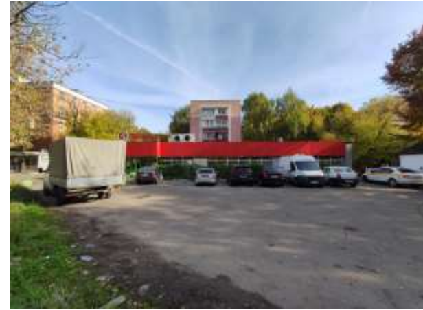
Общий вид здания
