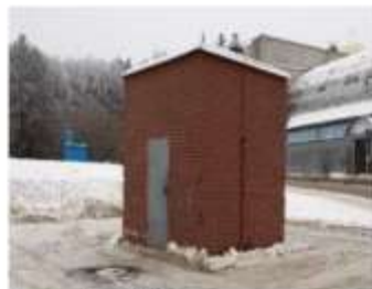
Здание КНС отдельностоящее
