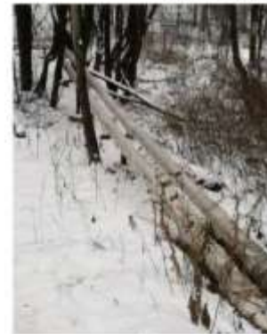
Открытый участок теплотрассы (на балансе объекта)
